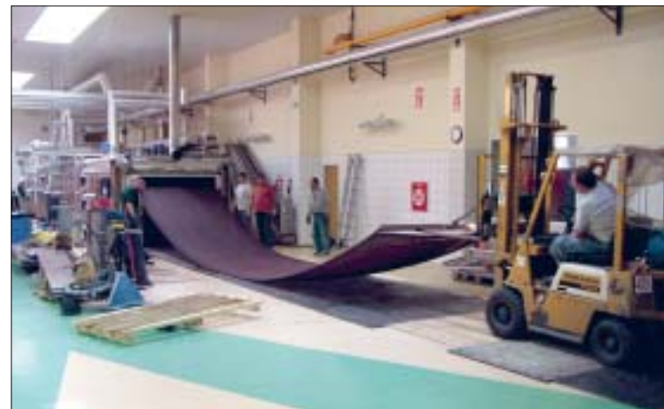
Výstavba nové pece na běžné pečivo. V hlavní roli budoucí pec a lidé z adélkovské údržby.
